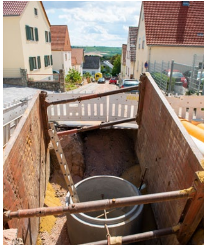
Kanalerneuerung am Ulzheimer Weg
